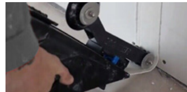
Giunto su angolo Corner Joint
